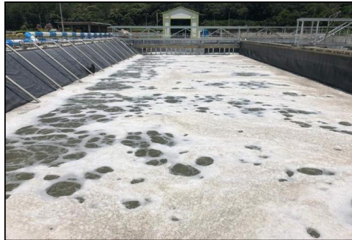
Tanque de aireación No. 1
