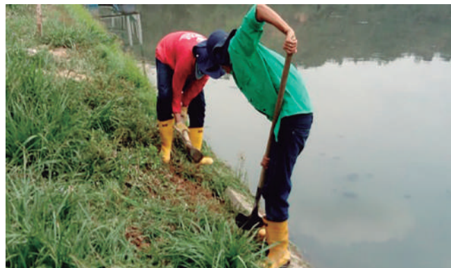
Limpieza de losas de la laguna facultativa No.2.
