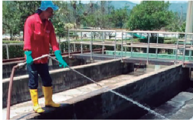
Lavado de paredes y vertederos del desarenador
