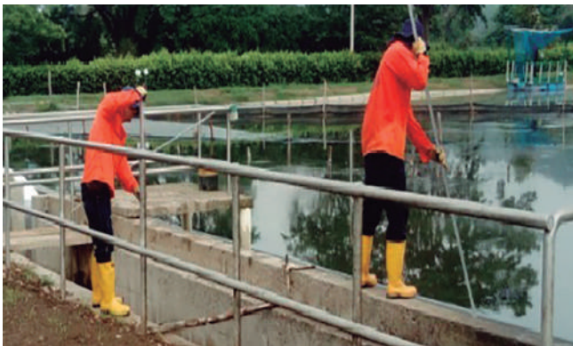
Lavado vertederos de la laguna.
