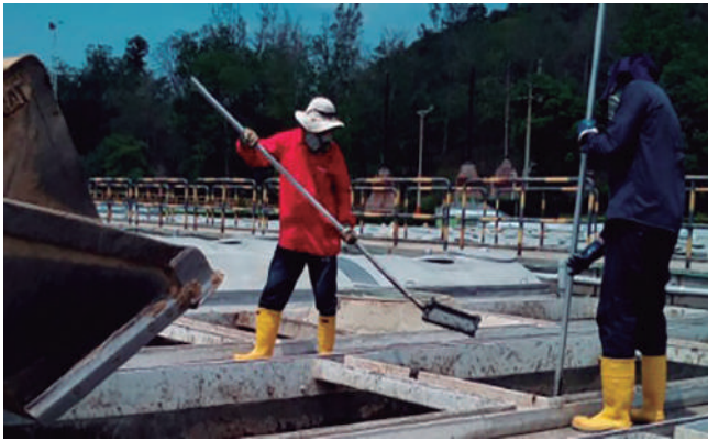
Limpieza de vertederos de agua en los reactores UASB
