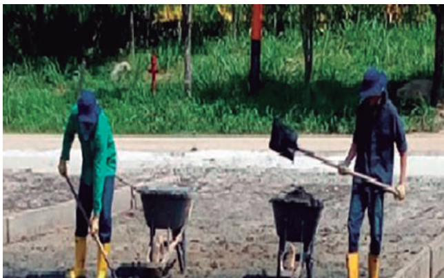
Retiro de lodos de los lechos.
