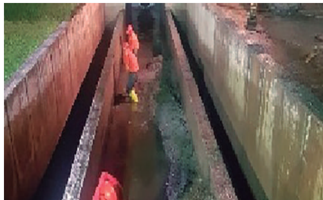
Limpieza de arena y lodo en el canal de entrada.
