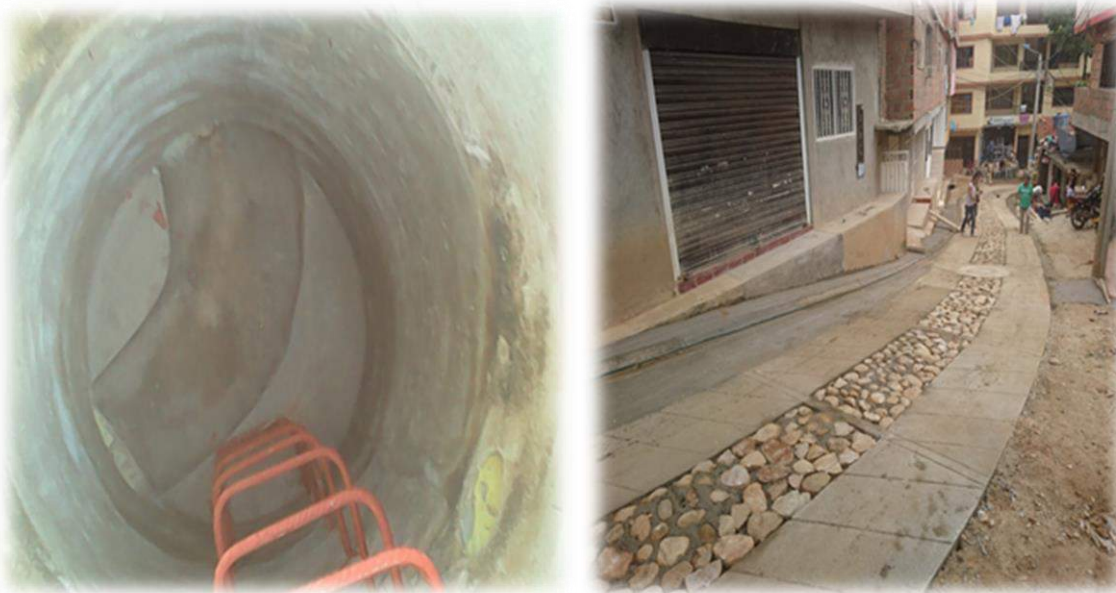
Red de alcantarillado y urbanismo terminado tipo
