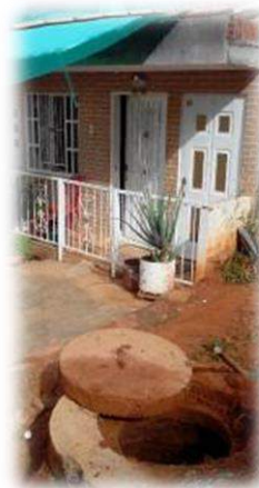
Verificación de conexión al sistema alcantarillado público (pozo de inspección), Barrio La Ronda III
