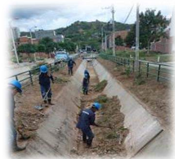
LIMPIEZA CANALETA PERIMETRAL AL BARRIO CAMBULOS QUE CONDUCE AGUAS
