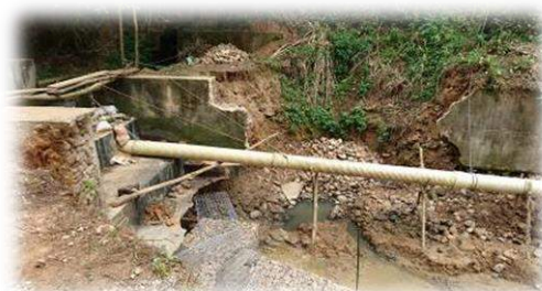
Reconstrucción Piso del Canal Quebrada Chocoita
