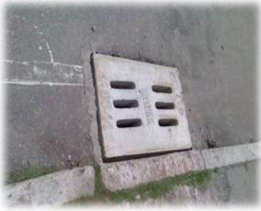
Cambio de Rejilla en concreto – Portal de Jericó
