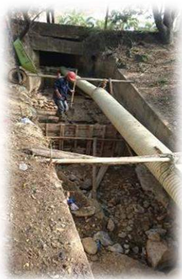
Muro En Gaviones Km 4 Quebrada La Iglesia
