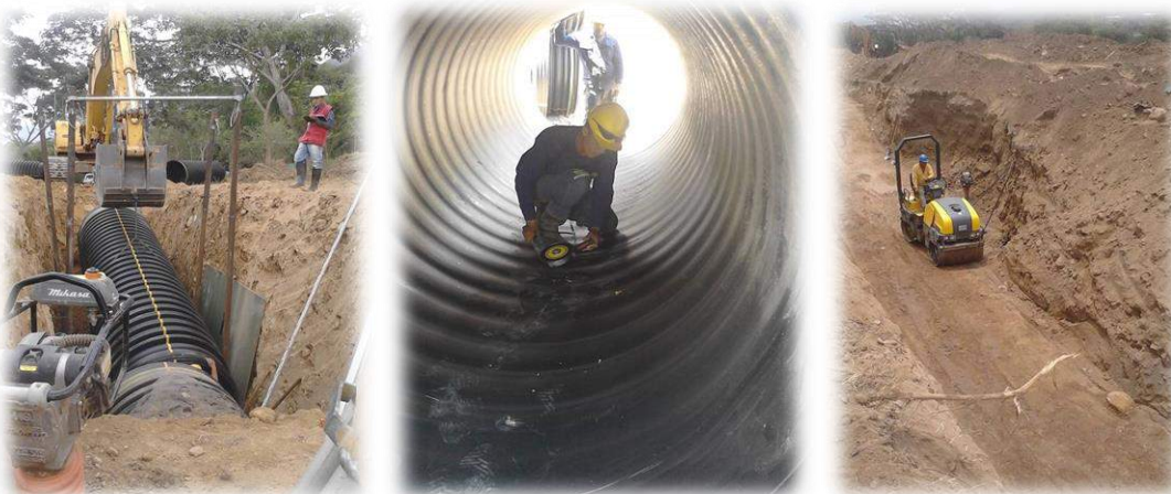
Replanteo, Control y Medición Excavación en zanja Encamado, acostillado y relleno inicial de la tubería en arena
