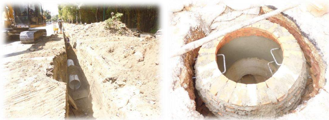
Instalacion de tuberias y construccion de pozos de inspección
