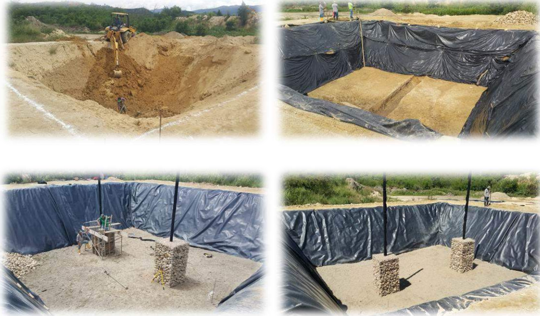
Detalle proceso constructivo Relleno Sanitario
