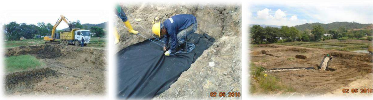
Detalle proceso constructivo celdas de lodos.
