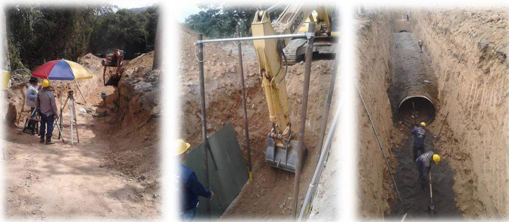
Replanteo, Control y Medición Excavación en zanja Encamado, acostillado y relleno inicial de la tubería en arena
