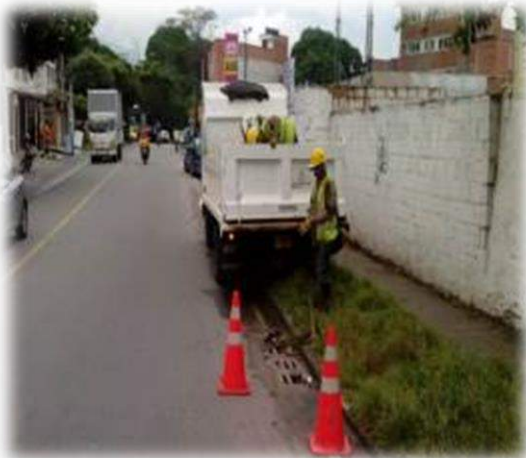
Limpieza del Sistema de Alcantarillado – Lagos I
