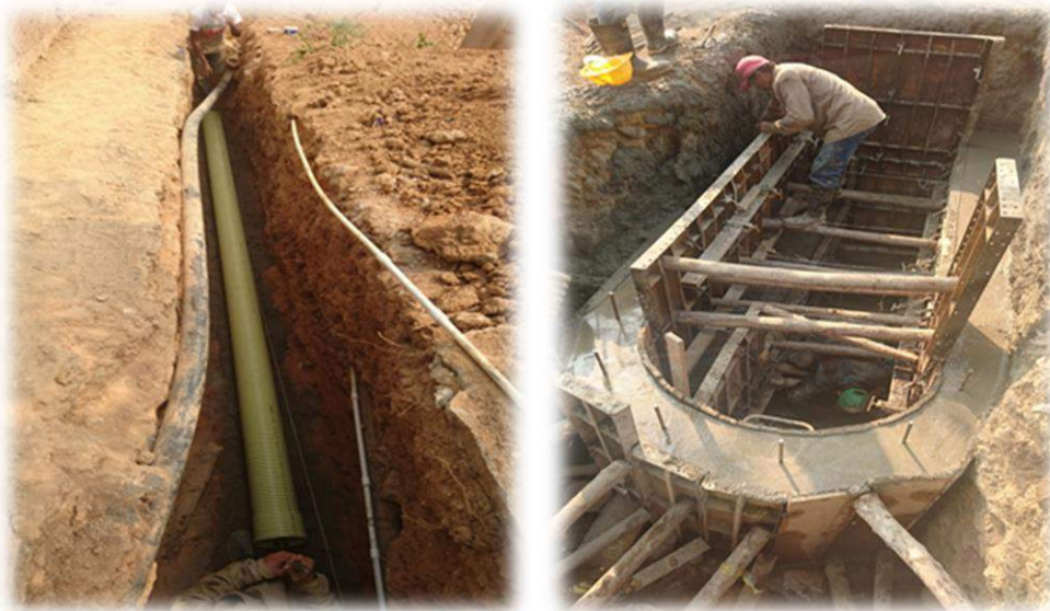
Instalacion de tuberias y construccion de estructuras de separacion
