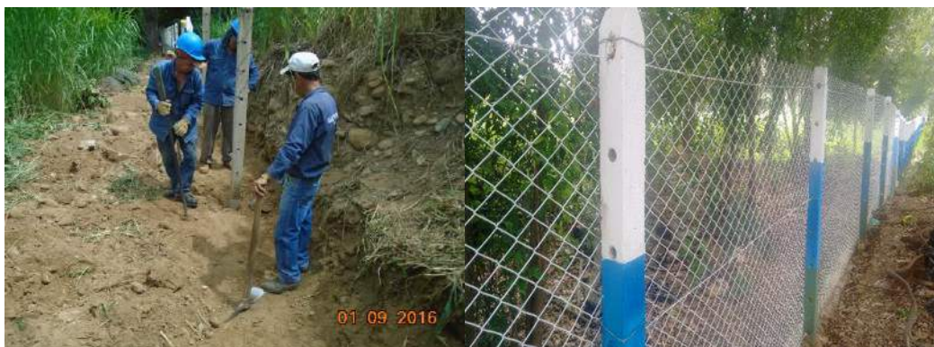
Detalle proceso constructivo encerramiento perímetro sur oriental.
