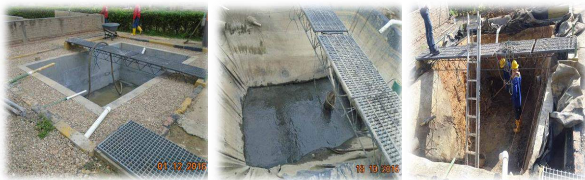
Detalle proceso constructivo Tanque Homogenizador del STARE.
